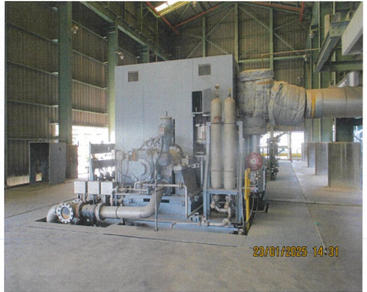
มาตรการควบคุมเสียงดังที่แหล่งกำเนิด (Cover guard)
