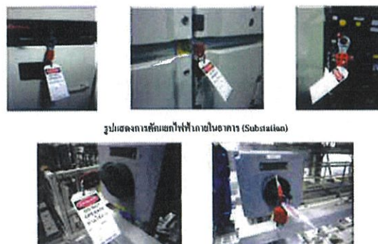
รูปแสดงการตัดแยกไฟฟ้าที่เขตจำหน่าย
